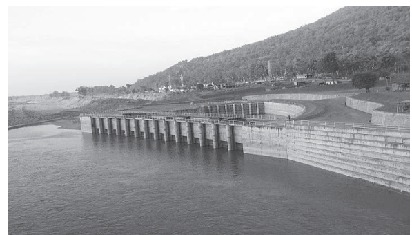
頭首工の完成
