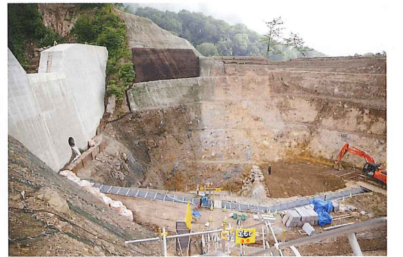
滝谷第1号砂防堰堤工事
