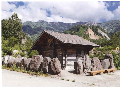
砂防工事で働く人々の疲れを癒やす「天涯の湯」
