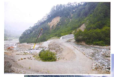
湯川第13号砂防堰堤工事
