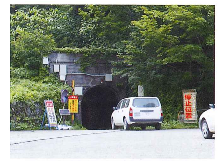
水谷出張所や各建設事業者の宿舎がある水谷平と現場をつなぐ道は白岩トンネルだけ。旧軌道線時代のまま使っているので車幅と同じくらいの狭さ。
