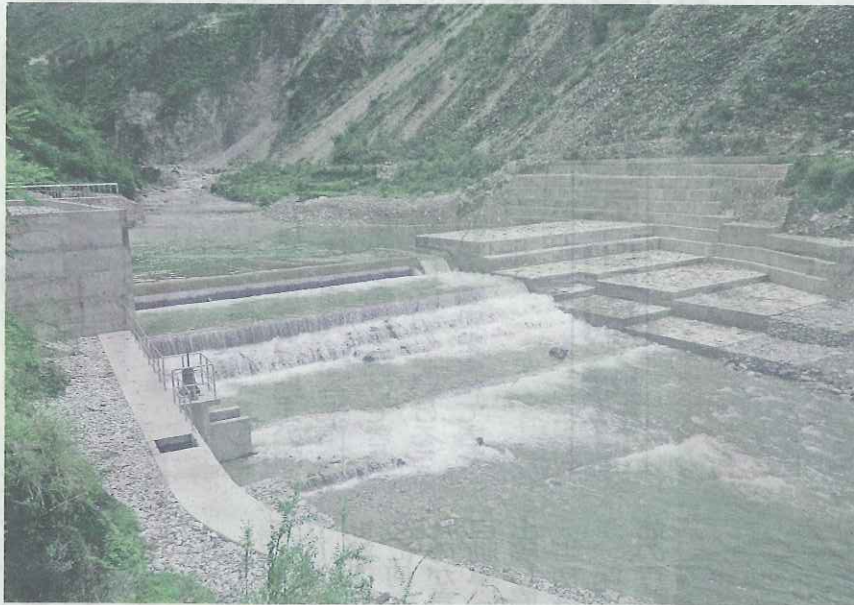
改修工事が最終段階となったネパール・バジャンの小水力発電所
