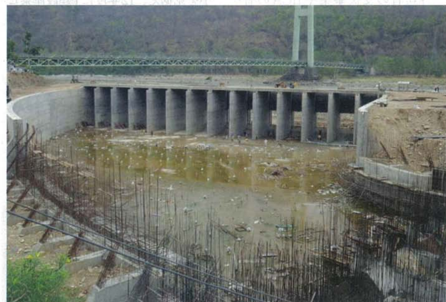
丸新志鷹建設が手掛けるネパールのカルナリ川のかんがい頭首工工事の現場。2013年6月の水害で工期が当初の13年8月から14年6月に延びた(写真:丸新志鷹建設)
