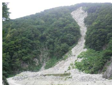
右岸側崩壊斜面
