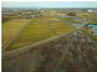
完成(南側より)
