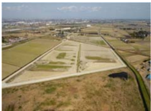
着手前(南側より)
