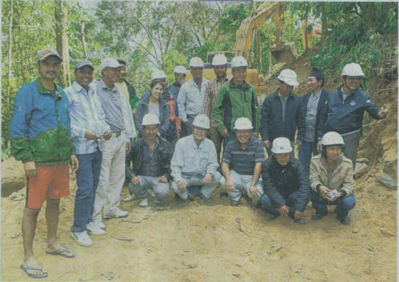
ブータンの国道工事現場で写真に納まる丸新志建設の社員と現地の作業員ら=1月(同社提供)
