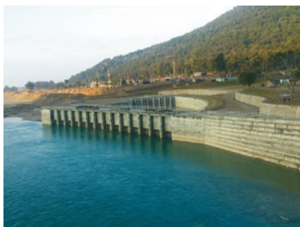
丸新志鷹建設がネパールで手掛けた現場
